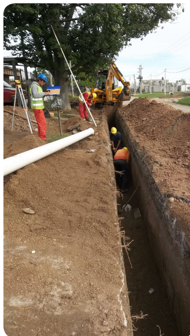
Casabó: Construcción de redes (2012)
