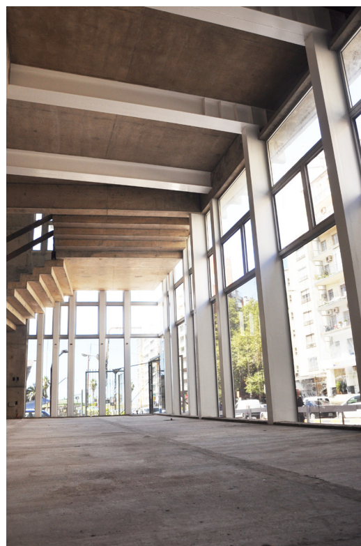
Hall de Ingreso
