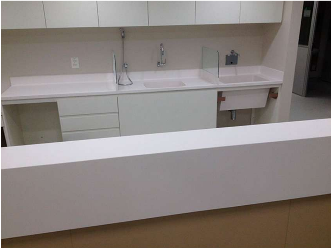
Imagen. Ejemplo de muebles de laboratorio con bajomesada, aéreo y mesadas con zócalo sanitario.
