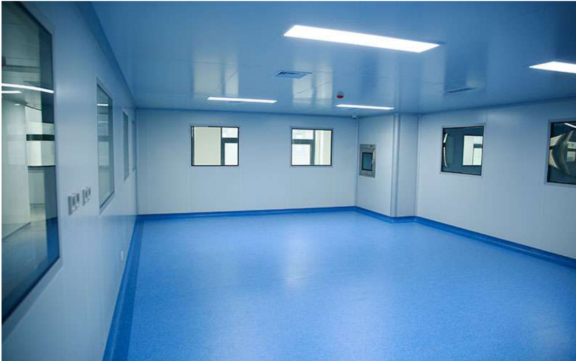
Foto. Sala limpia terminada con piso vinílico y zócalo sanitario vinílico.
